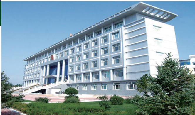
Budova vlády v Číne.
