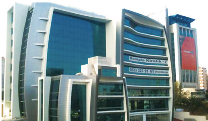
Kancelářská budova v Istanbulu, Turecko.
